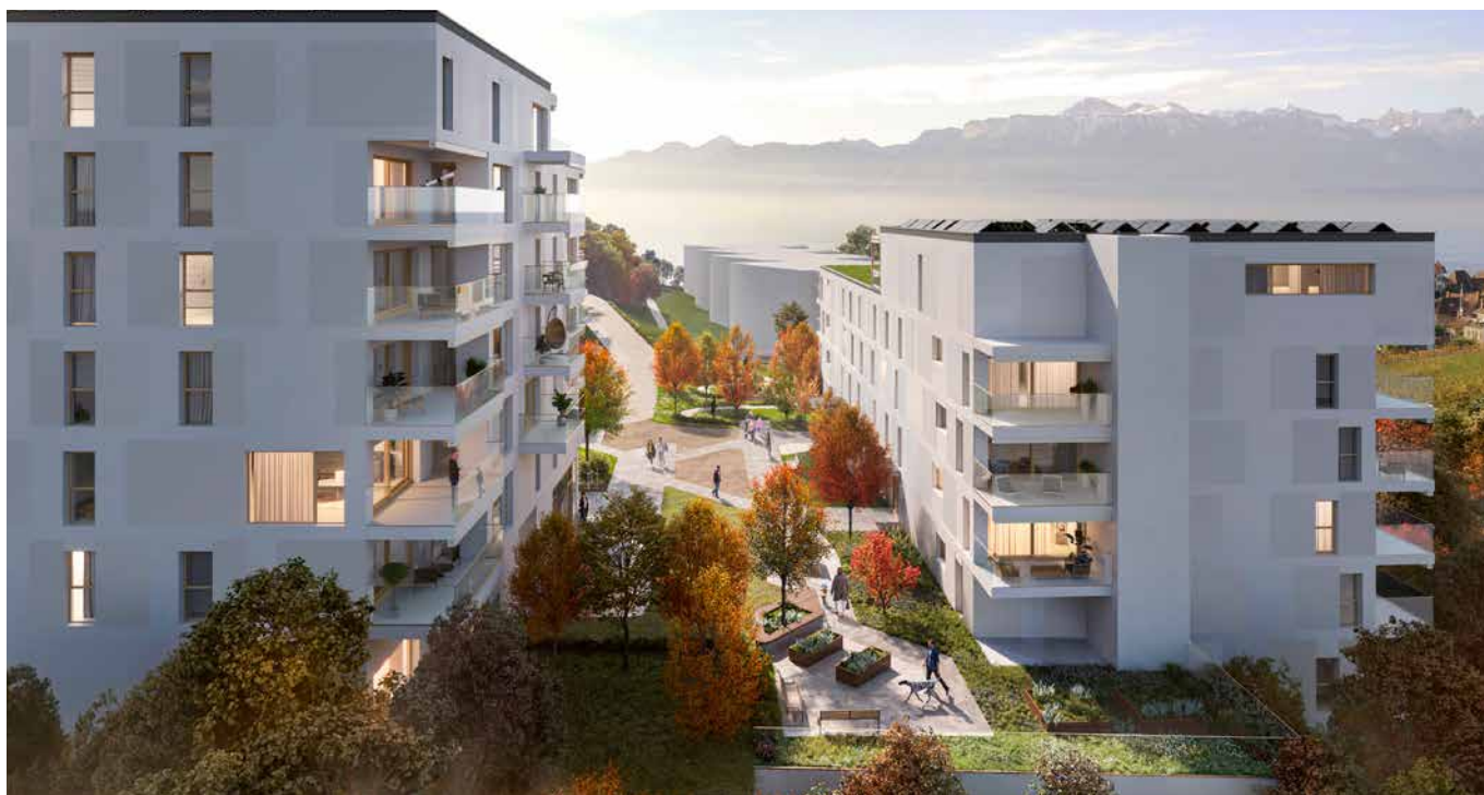
Bauprojekt an der Route des Monts-de-Lavaux in Belmont-sur-Lausanne mit SNBS-Gold-Zertifizierung in einer naturnahen Umgebung
