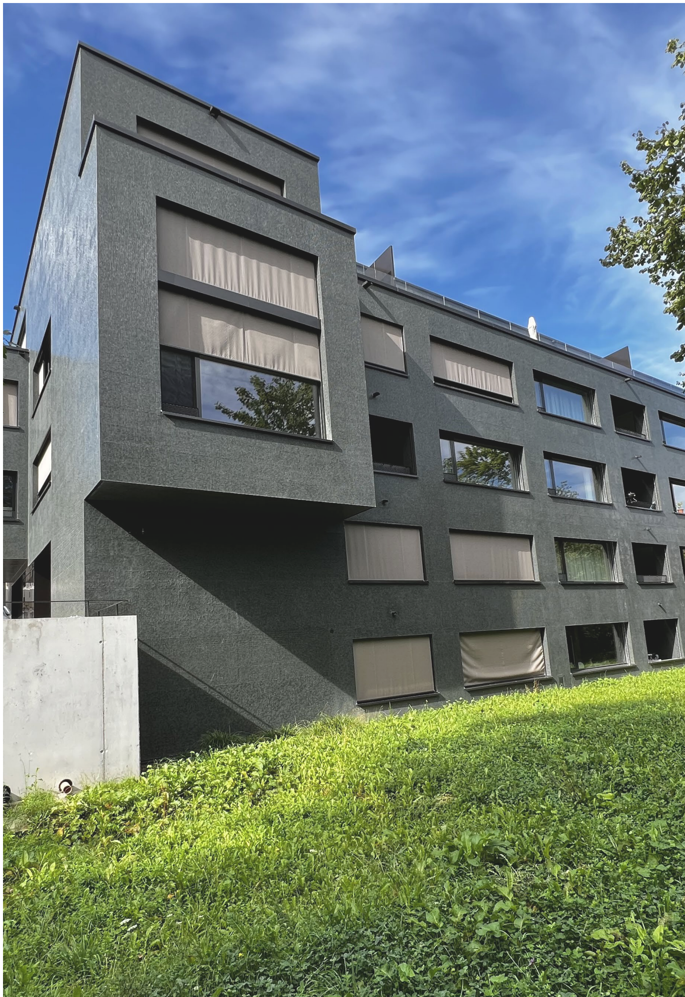
Foto: Zürich, Forchstrasse 275, 277, 279
