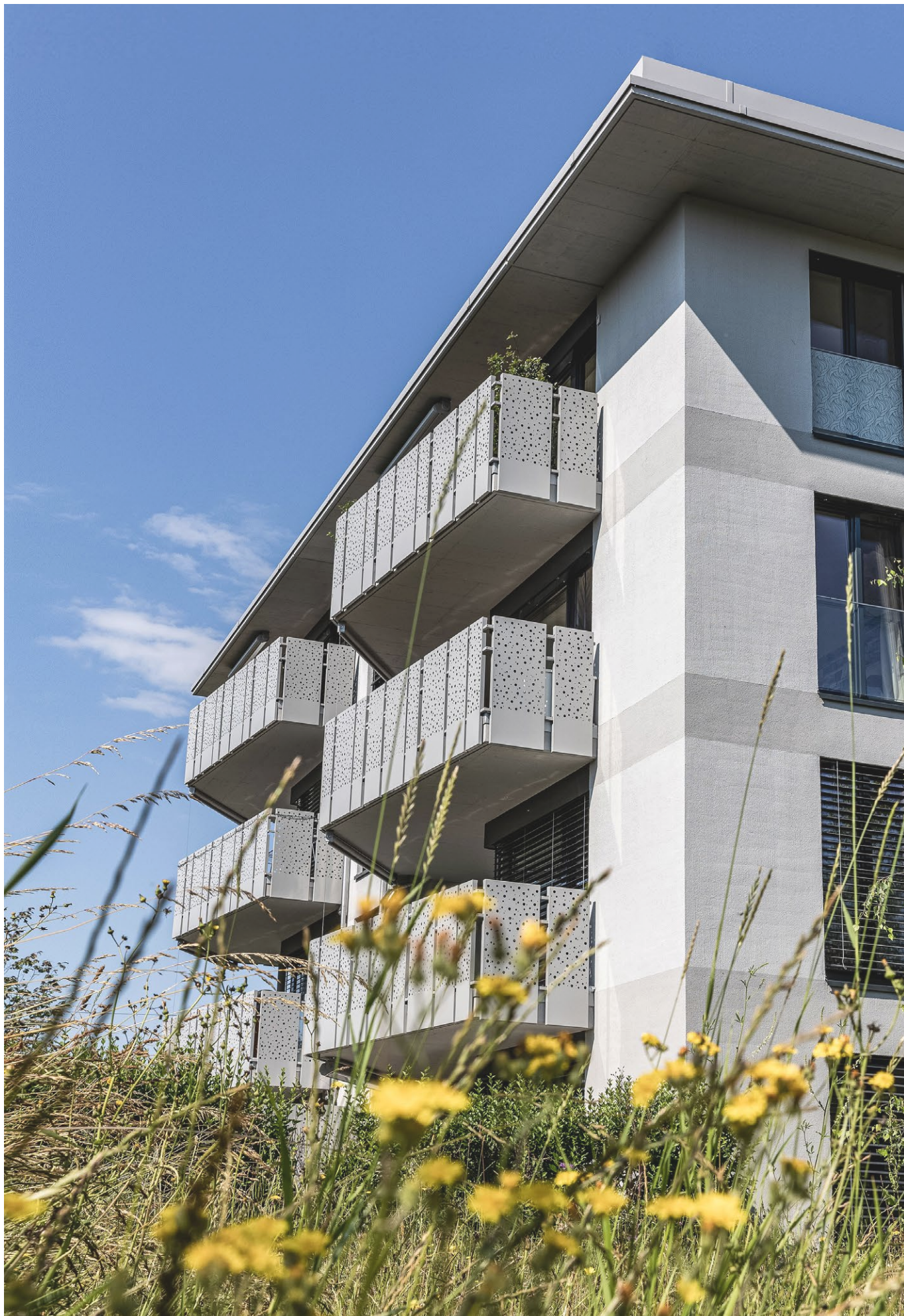
Foto: Fehraltdorf, Wermatswilerstrasse 20
