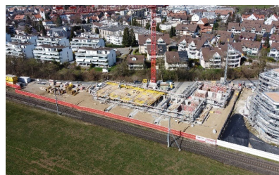
Fehraltorf (ZH), Wermatswilerstrasse 20: Neubau
