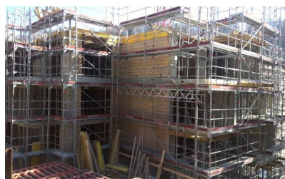
Zürich (ZH), Soodstrasse 90 bis 96: Neubau
