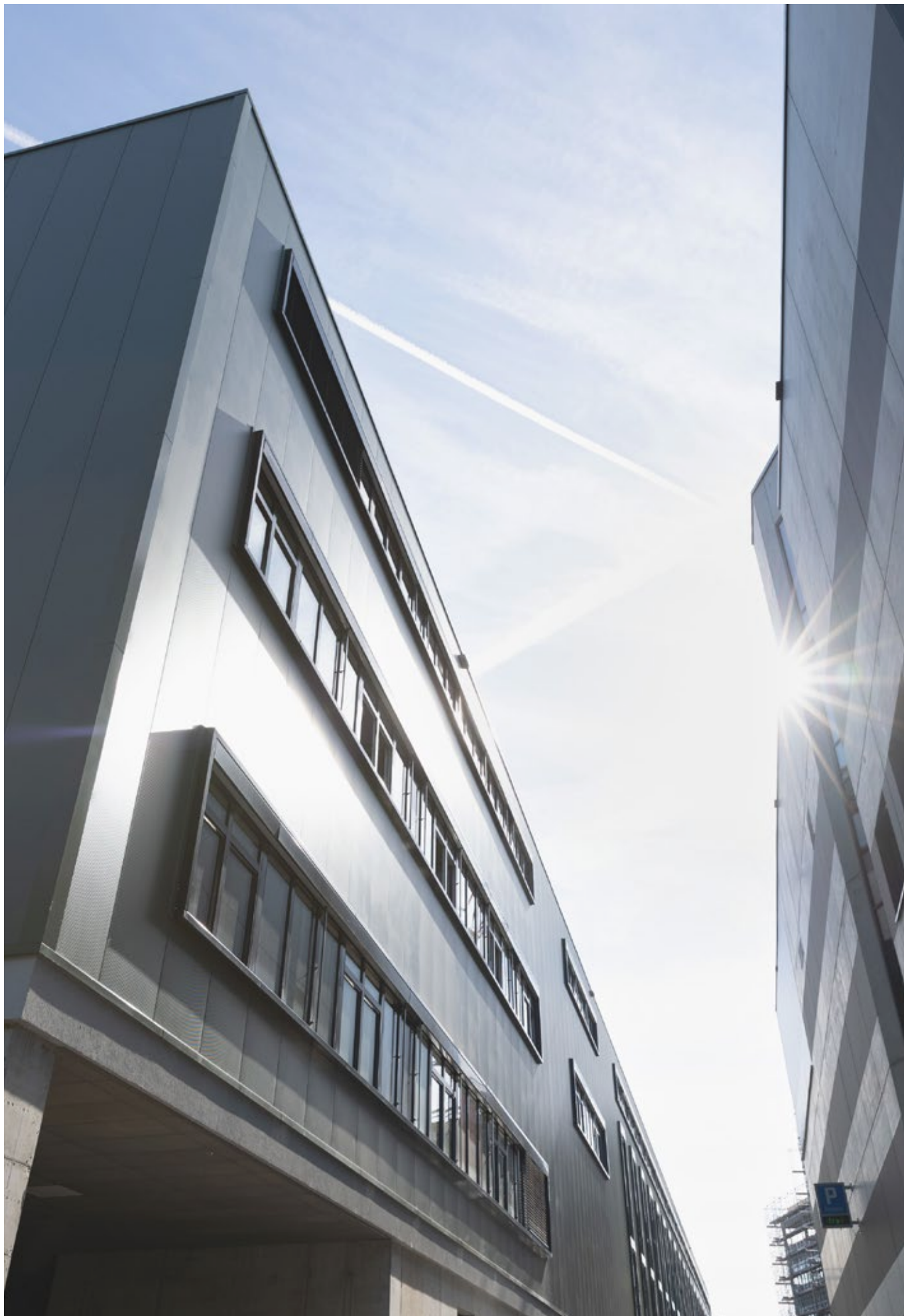
Photo: Rütihof 8-12, Wädenswil (ZH)
