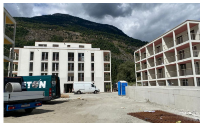
Brigue-Glis (VS), Jesuitenweg 28 à 32 : construction nouvelle
