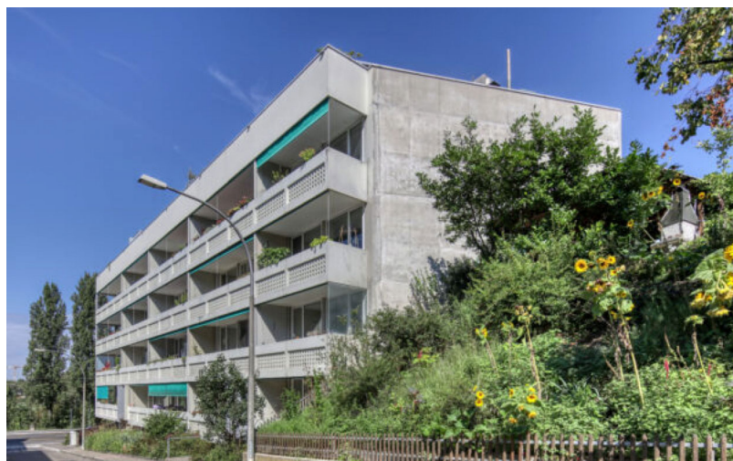
Riehen (BS), Lörracherstrasse 68/Friedhofweg 1 et 3 | Année d'acquisition : 2019 | Valeur vénale : 17,04 millions de CHF | Logement
