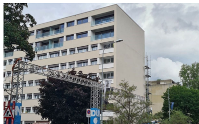
Meyrin (GE), Rue de la Prulay 39 et 45 : surélévation
