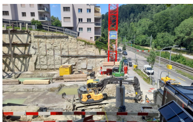
Zurich (ZH), Soodstrasse 90 à 96 : Excavation
