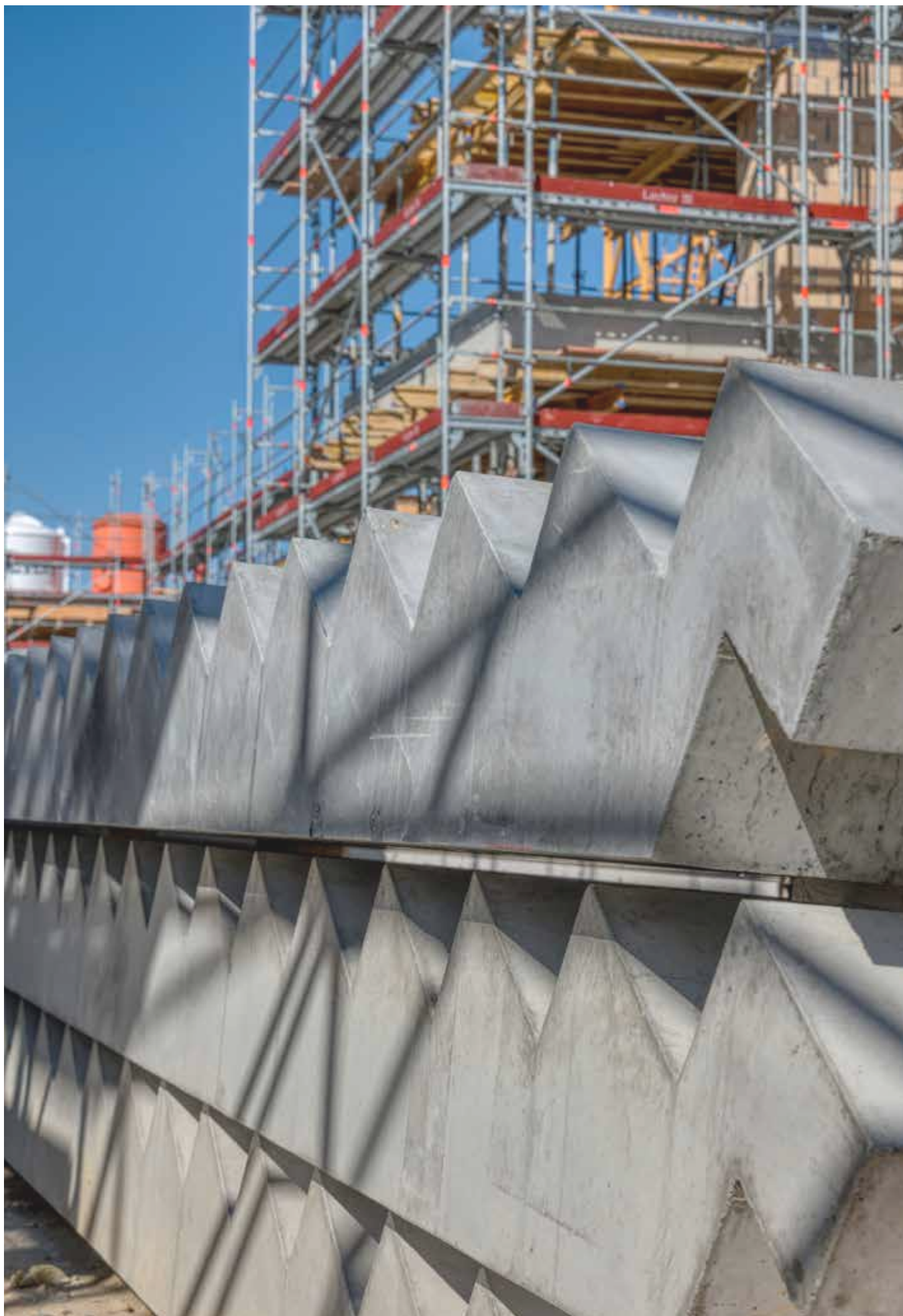
Utikon (ZH), Leuen Waldegg | Année de construction: 2023 | Volume du projet (prévu): CHF 164,22 Mio | Revenu locatif [THÉORIQUE]: CHF 6,15 Mio
