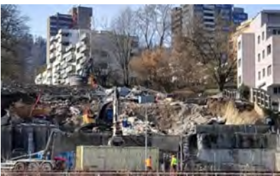
Zürich (ZH), Soodstrasse 90 bis 96: Baugrube
