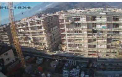
Locarno (TI), Via Bartolomeo Varenna 20a und 20b: Neubau
