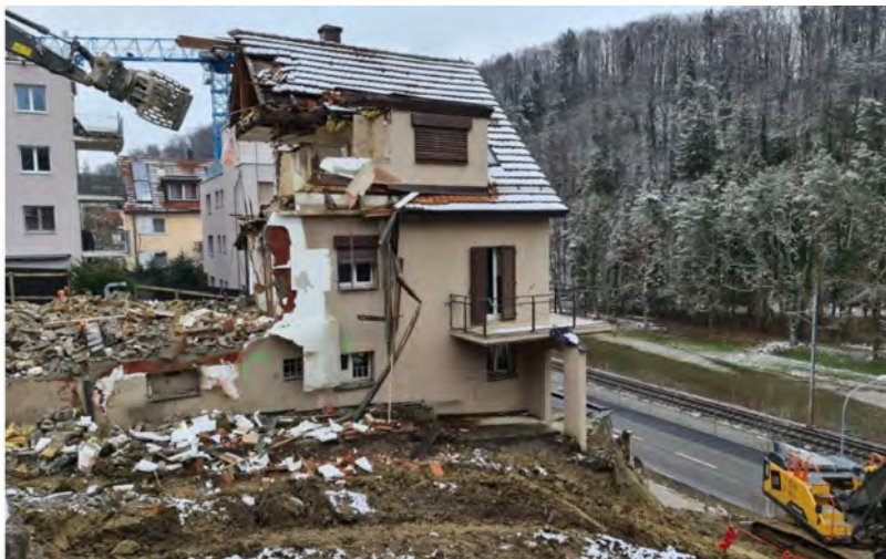
Zürich (ZH), Soodstrasse 90 bis 96: Abbruch
