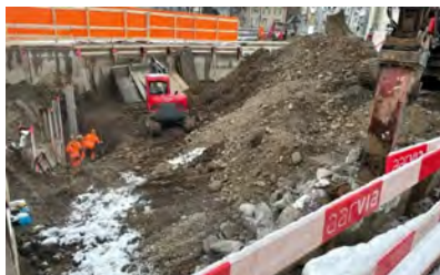
Baden (AG), Brown Boveri Platz 4: Baugrube
