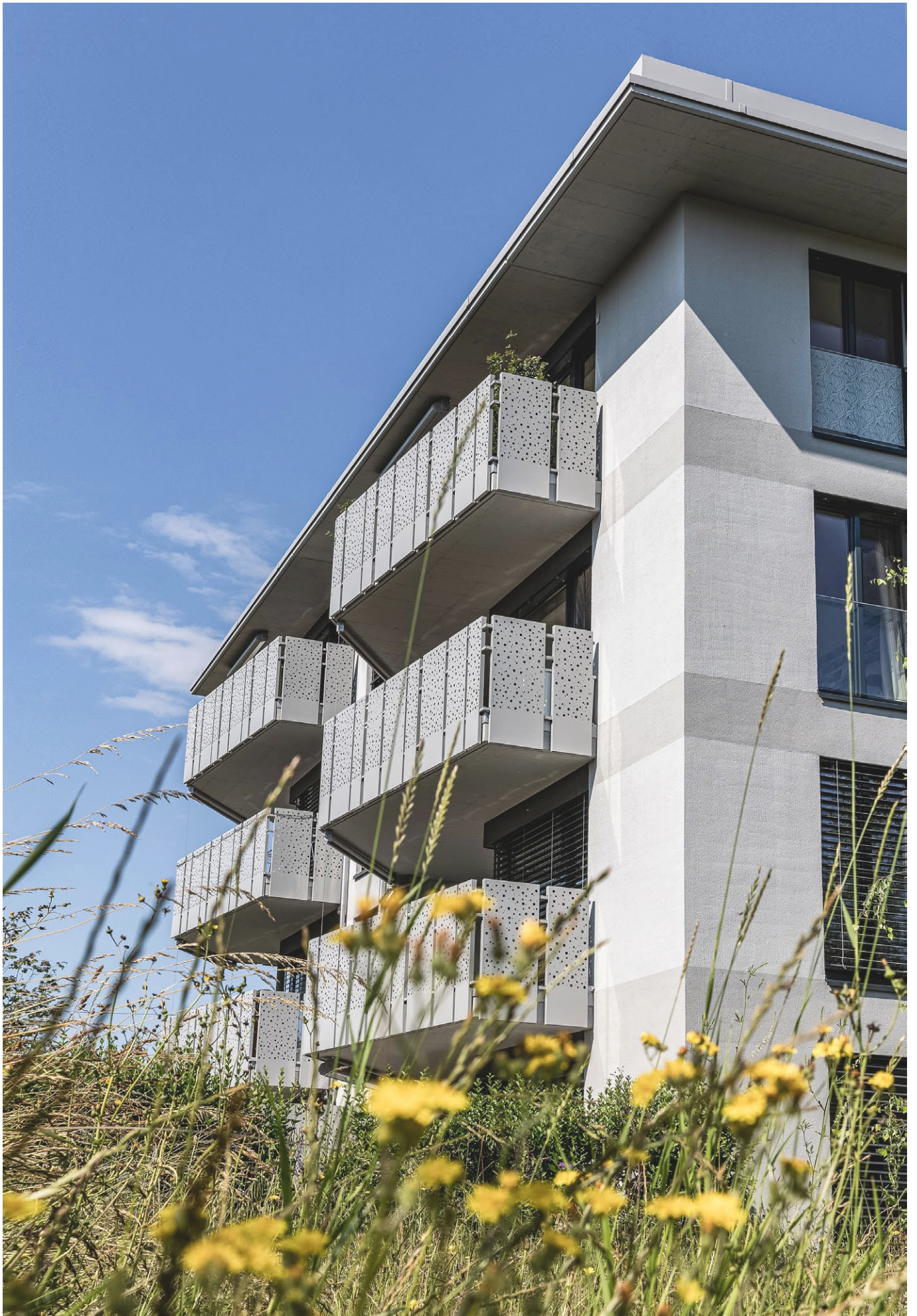
Foto: Fehraltdorf, Wermatswilerstrasse 20
