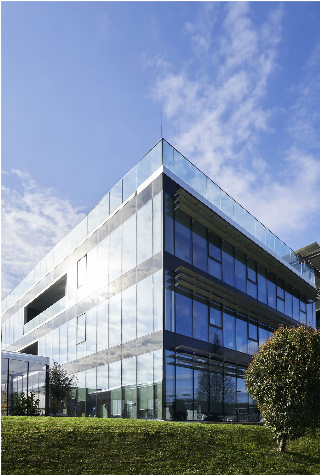
Foto: Via Laveggio 5, 6855 Stabio
