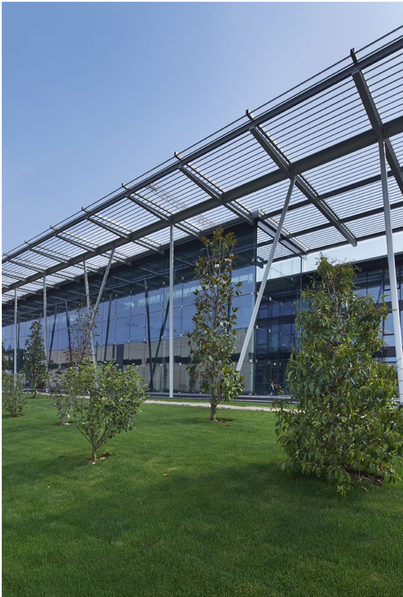
Foto: Via Laveggio 5, 6855 Stabio
