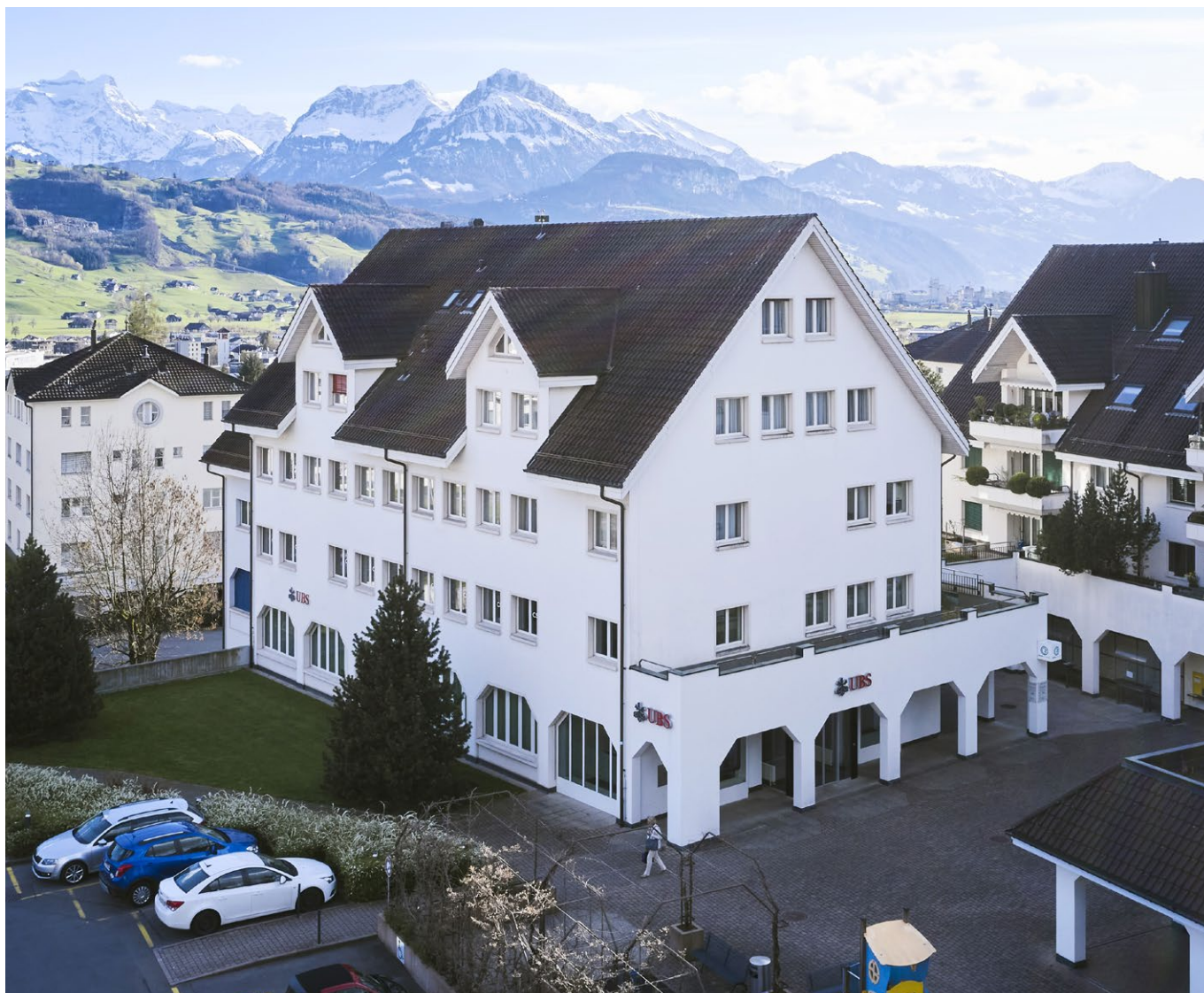
Foto: Oberer Steisteg 18/20, 6430 Schwyz
