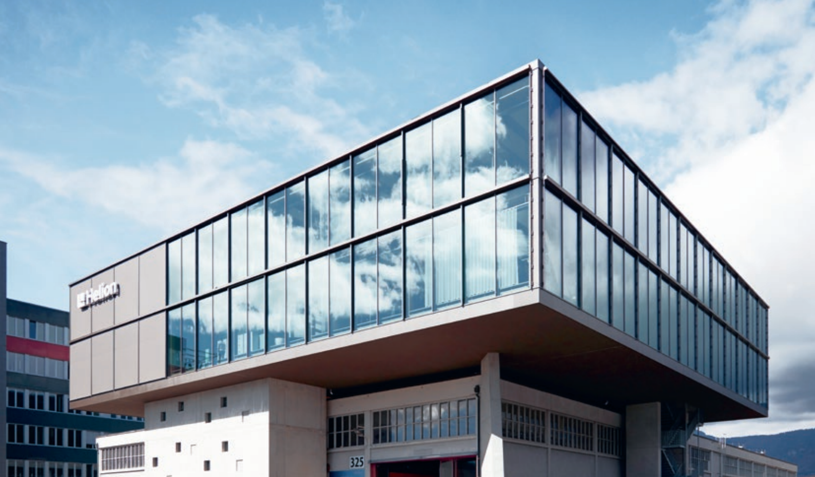
«Rivernest» – der zweigeschossige Büro kubus aus Holz und Glas
