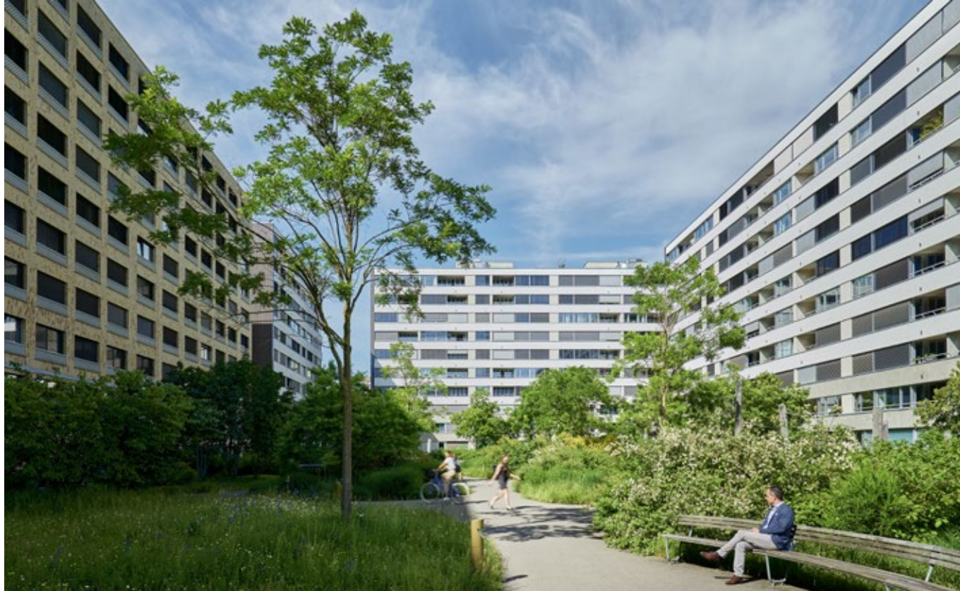
Überbauung «Maaghof» in Zürich West
