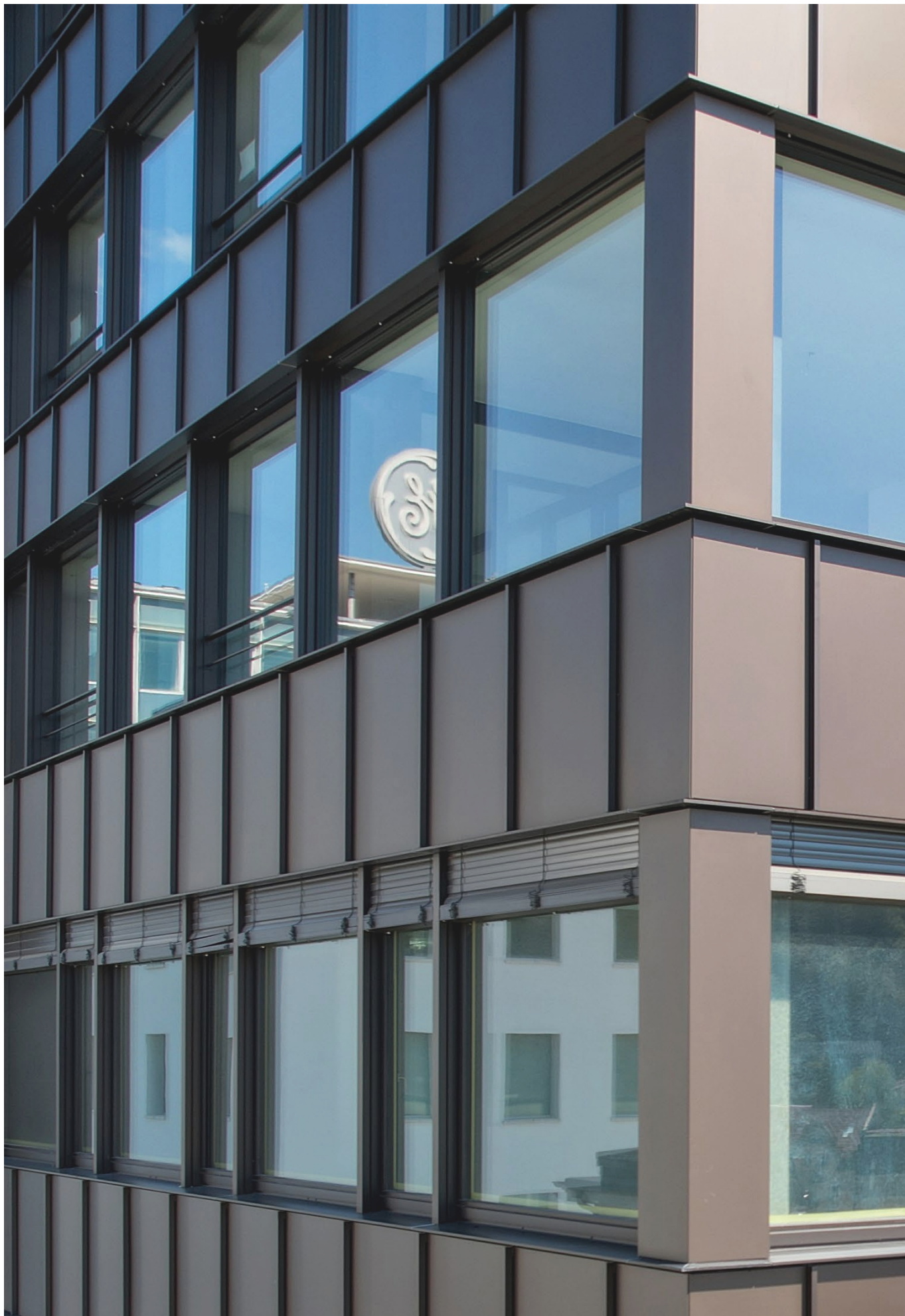
Foto: Akara Tower, Brown Boveri Platz 4, 5400 Baden
